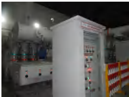
SVG 室内部控制柜、灭火器、火警报警器等
