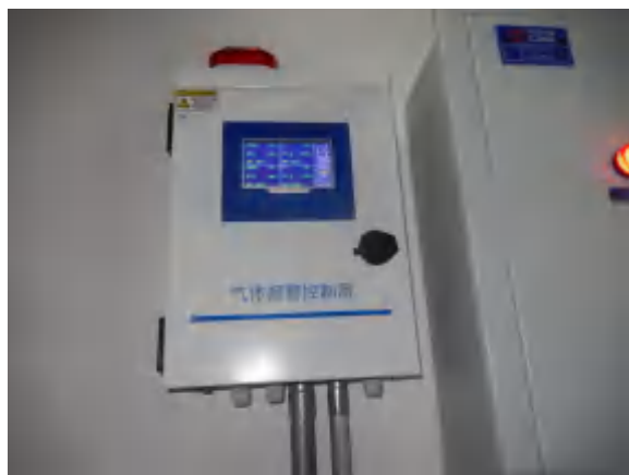
220KV 配电装置楼内部、气体报警器、火警报警器
