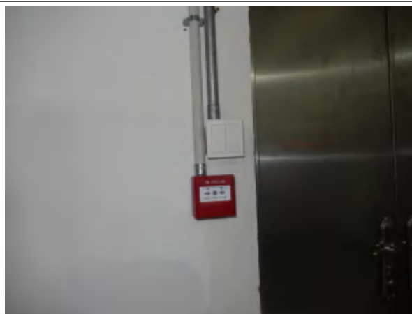
220KV 配电装置楼内部、气体报警器、火警报警器
